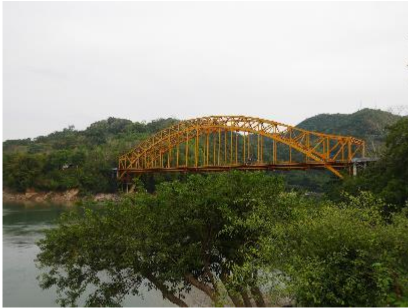
Figura 8. Fotografía del Puente de Boca del Cerro, cerca de Tenosique (abril 2018, CH)
